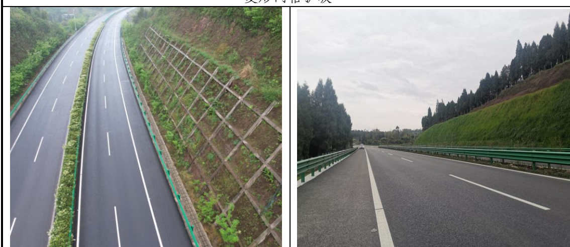
框格护坡+喷播植草
